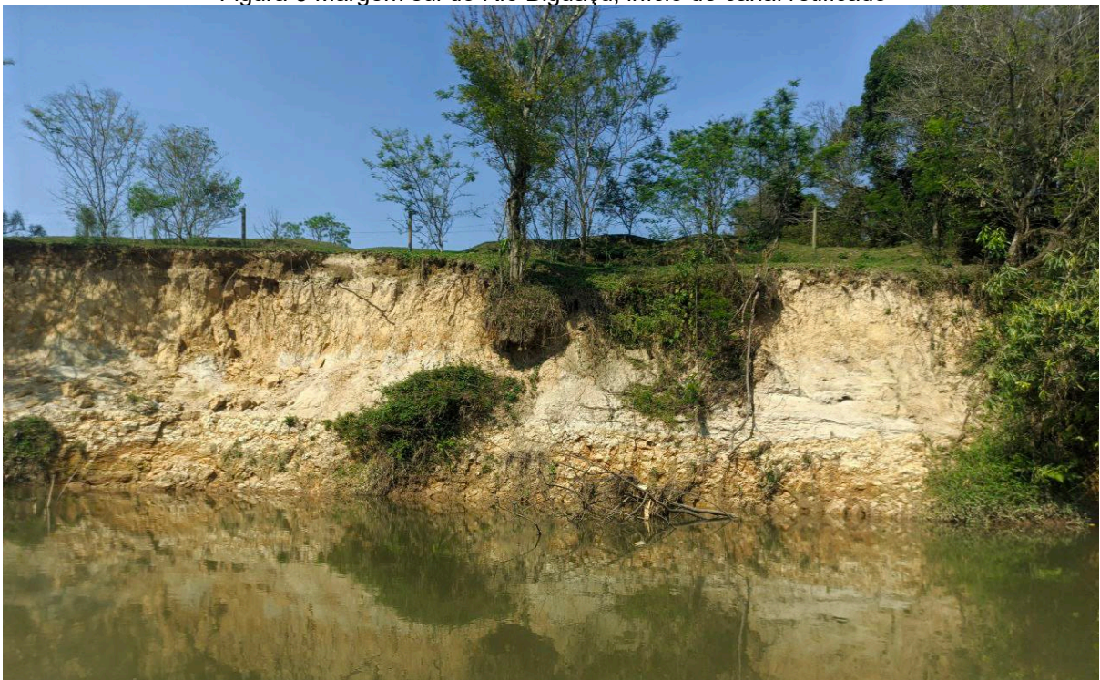
Figura 3 Margem sul do Rio Biguaçu, início de canal retificado
