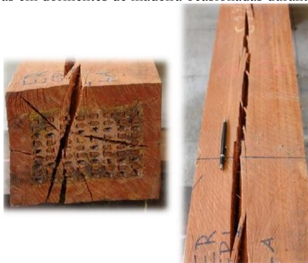
Figura 8 – Rachaduras em dormentes de madeira ocasionadas durante a perda de umidade.
