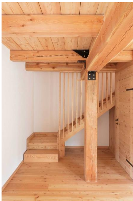
Figura 1 – Obra exclusivamente feita com estruturas de madeira.
