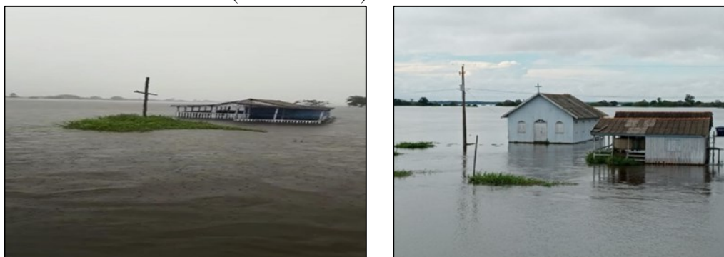
Figura 64 – À esquerda: Salão Social e à direita a Igreja e a Escola Municipal Nossa Senhora de Nazaré e cozinha do salão social (a direita de lado) durante a enchente de 2021
