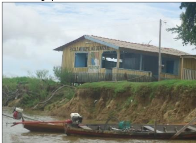
Figura 29 – Antigo prédio da Escola Nossa Senhora de Nazaré (2013)
