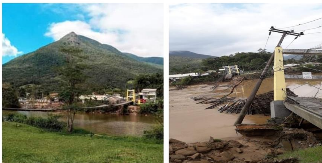
Figura 22 – o antes e o depois da enchente de 2022 na área da ponte
