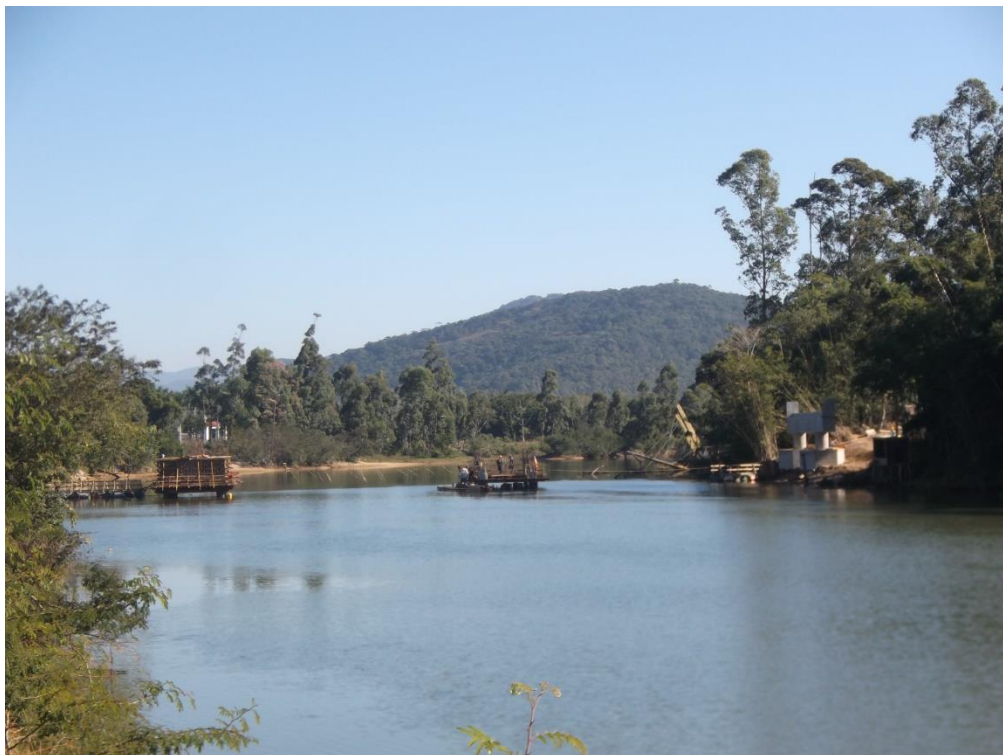
Figura 23 – construção de nova ponte sobre o rio Cubatão no bairro Guarda do Cubatão
