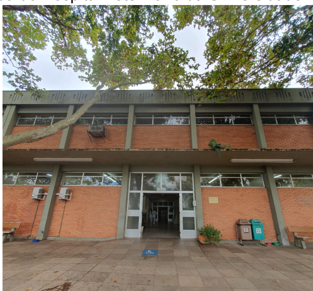
Figura 8 - Fachada do Hospital Veterinário da Universidade Luterana do Brasil.
