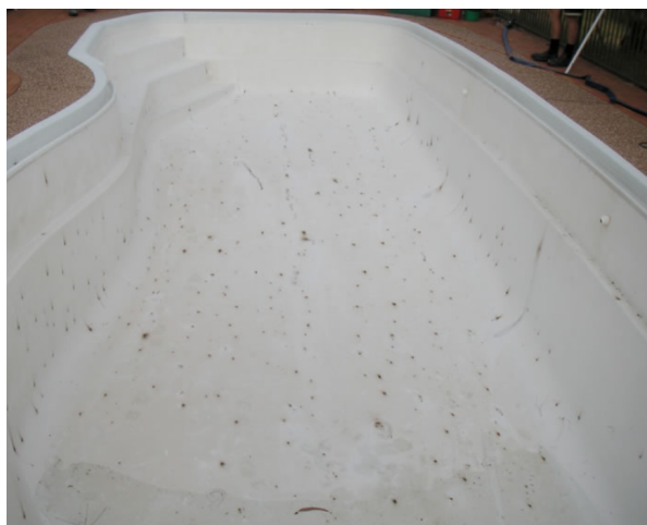
Figura 26 – Manchas de origem inorgânica em piscina de fibra
