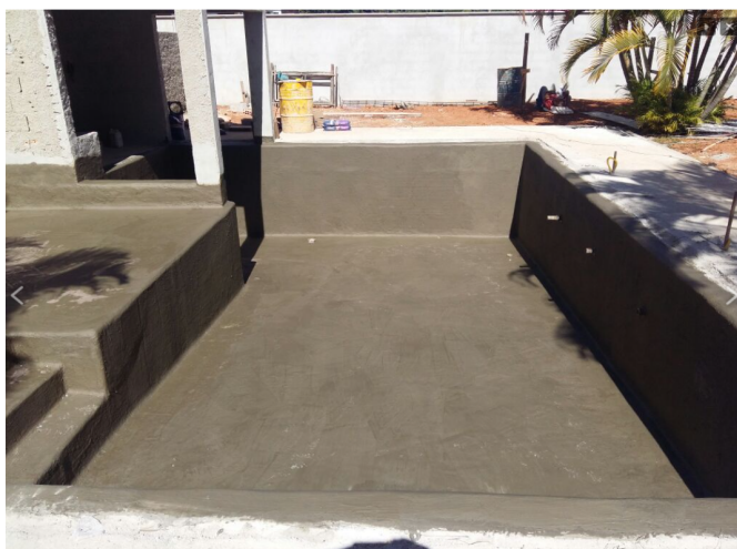
Figura 10 - Impermeabilização de piscina com argamassa polimérica
