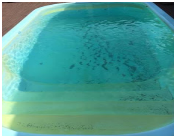
Figura 27 - Manchas de origem orgânica em piscina de fibra
