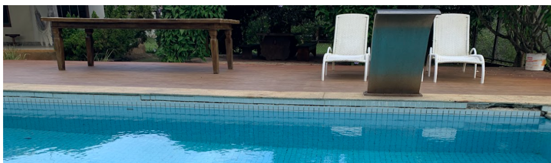
Figura 40 – Fissura horizontal na face leste da piscina
