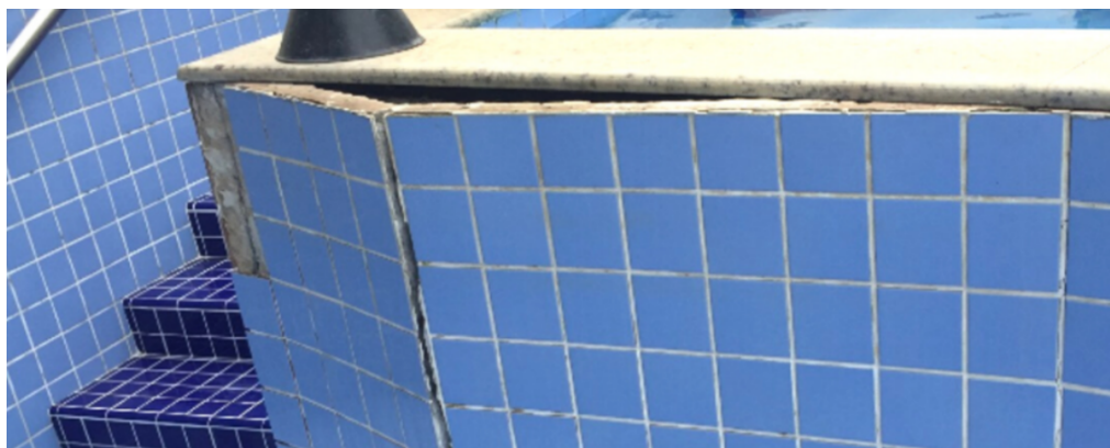
Figura 15 – Deslocamento por perda de aderência com o substrato
