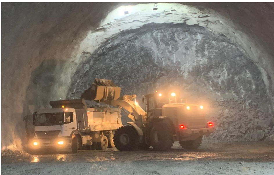
Figura 23- Limpeza após remoção do choco
