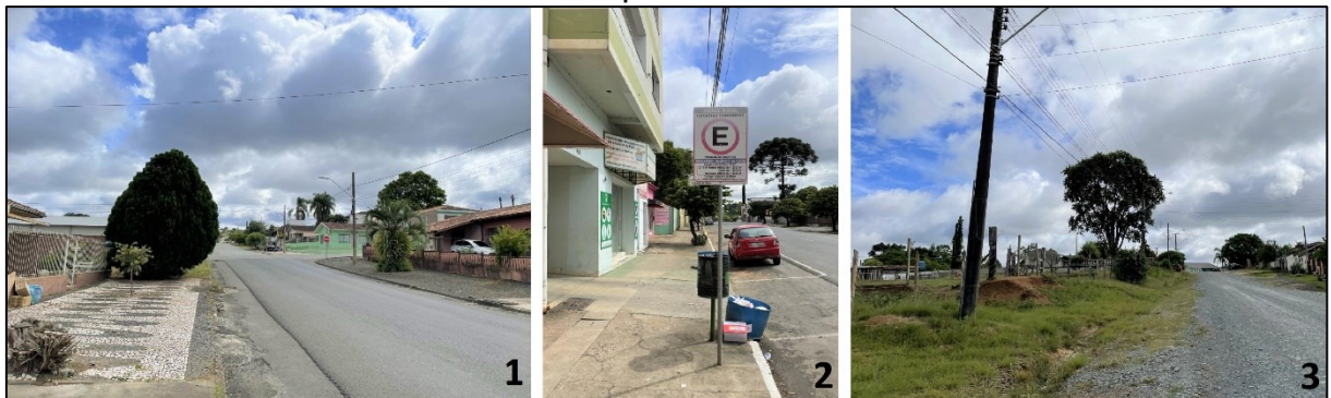
Figura 40 – Ruas da área urbana de Canoinhas – SC, com estruturas para o deslocamento pedonal ineficientes
