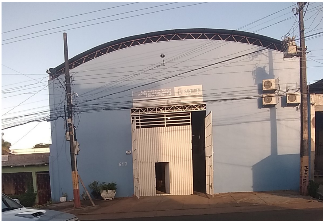
Figura 6 - Almojarifado Central e Centro de Abastecimento Farmacêutico de Santarém
