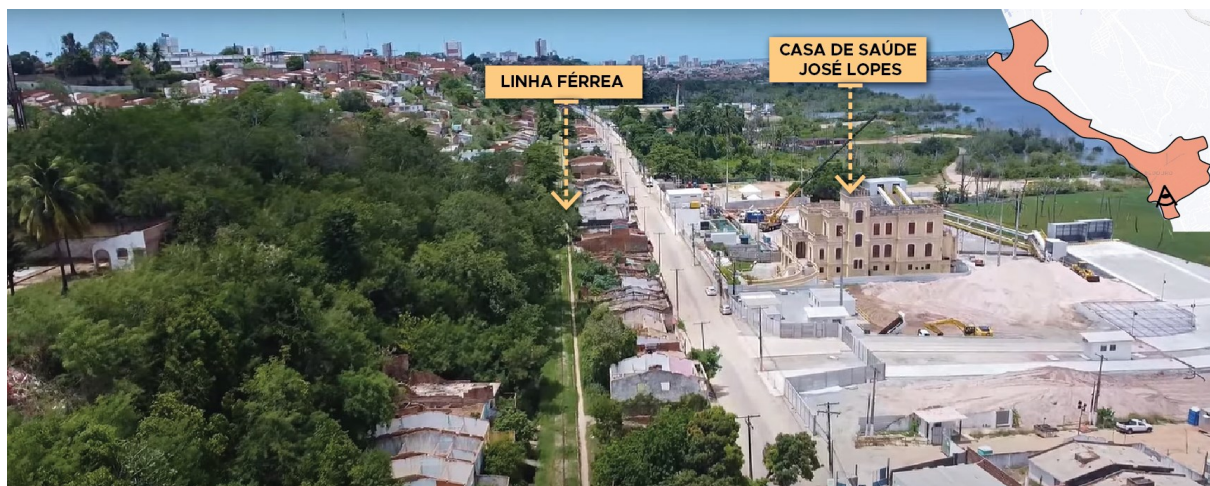
Figura 50: Vista aérea do bairro de Bebedouro com destaque para linha férrea e Casa de Saúde José Lopes.
