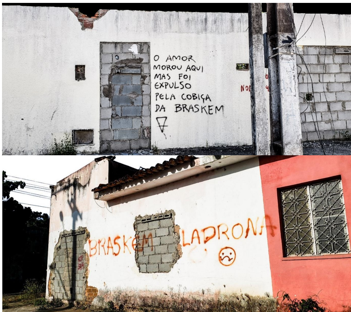
Figura 89: Vozes visuais nas casas destruídas.
