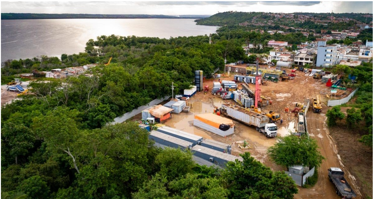
Figura 18: A empresa trabalhando na área para preenchimento das crateras subterrâneas.
