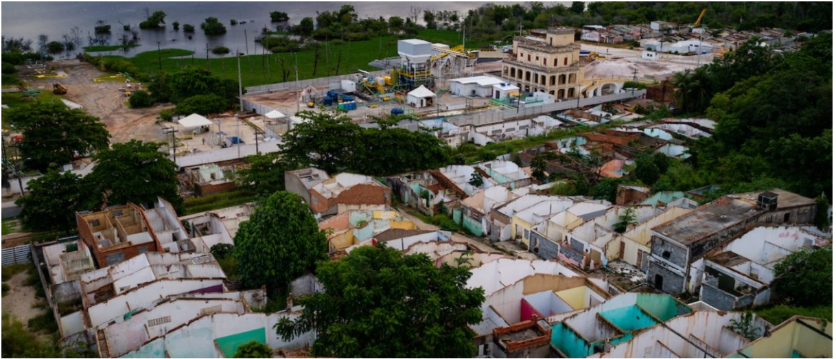
Figura 10: Vista aérea mostrando parte da área destruída pelo desastre.
