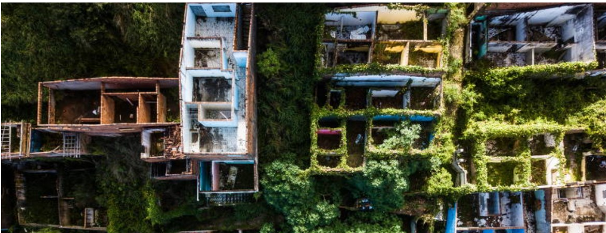
Figura 2: Cenário de destruição e de abandono da área afetada pelo desastre.
