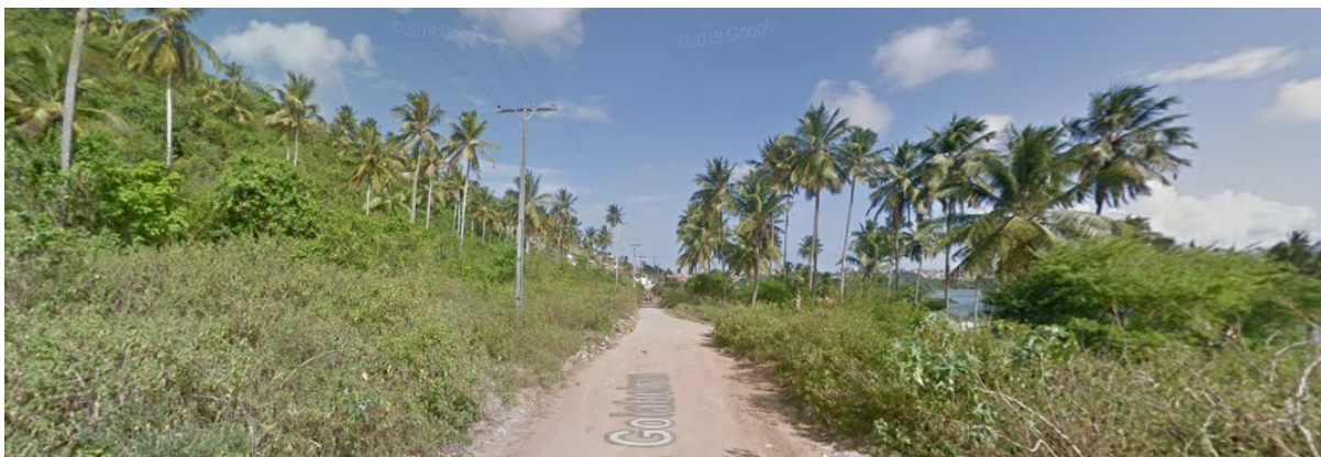
Figura 30: Parcela do bairro de Bebedouro com baixa ocupação e com deficiência em infraestrutura urbana.
