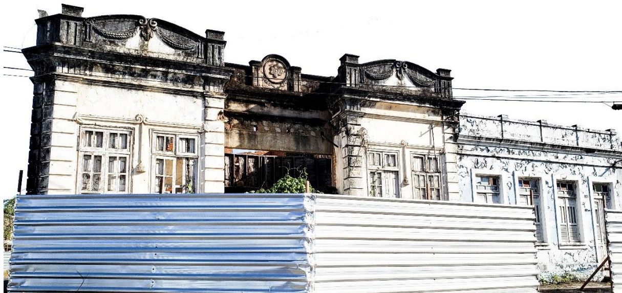
Figura 58: Edificações históricas com tapumes.
