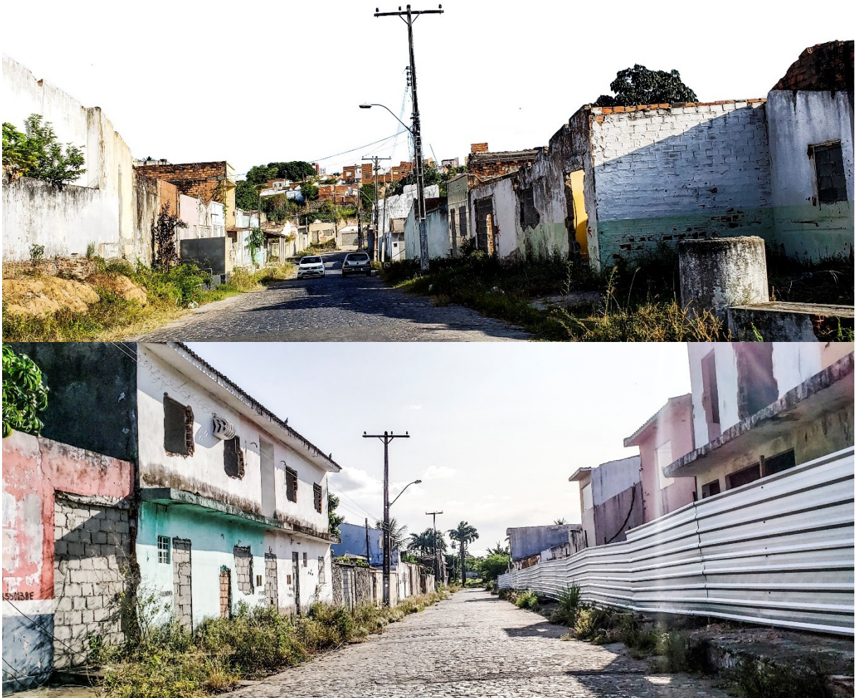
Figura 57: Ruas abandonadas e edificações deterioradas após desastre em Bebedouro.
