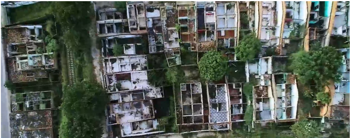
Figura 22: Vista da área mostrando destruição no local.
