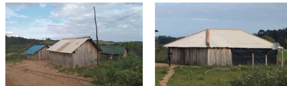
Figuras 7 e 8: Edificações em Madeira. Fonte: autoras.
