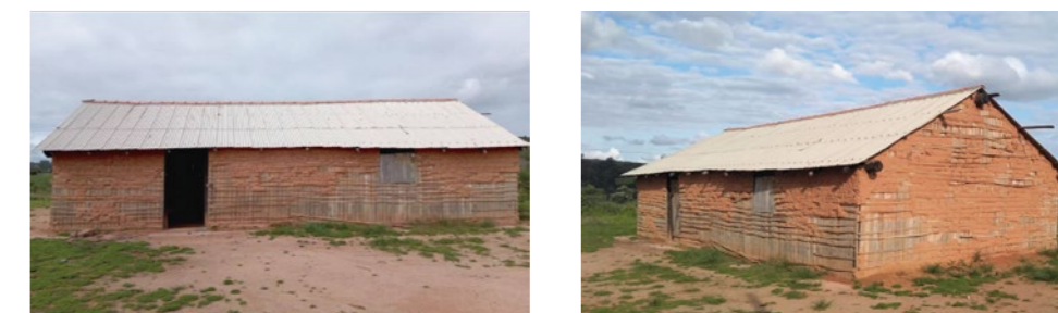
Figuras 11 e 12: Edificação em Madeira com Taipa de Sopapo. Fonte: autoras.
