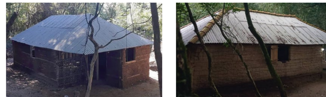
Figuras 9 e 10: Edificação em Pau-a-pique com Taipa de Sopapo. Fonte: autoras.
