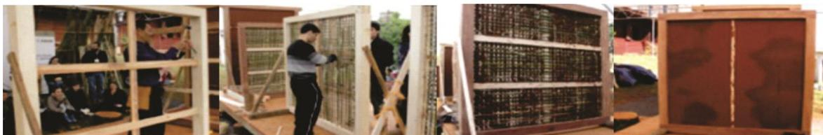
**Figura 4: (Da esquerda para direita) Trama auxiliar, amarração da malha de preenchimento, barro que extravasa pelo verso do painel, primeira camada concluída após secagem parcial e retração da argila no Painel desenvolvido no “Canteiro Escola Técnica Japonesa” USP, São Carlos, 2013. Fonte: Joaquim, 2015.**
