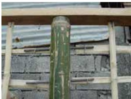
**Figura 7: Detalhe dos “pregos” de madeira unindo as lascas do tramado a estrutura em bambu roliço. Fonte: Ubidia, 2015.**
