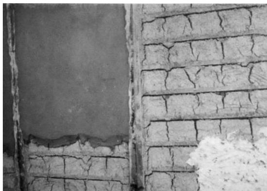
**Figura 2: Detalhe barreamento e reboco. Fonte: CEDATE, 1985.**
