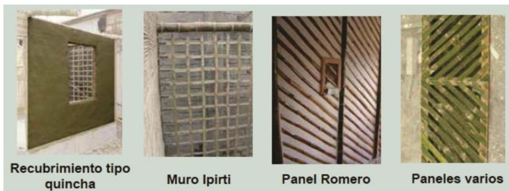
**Figura 6: Tipos de painéis de vedação. Fonte: Ubidia, 2015.**
