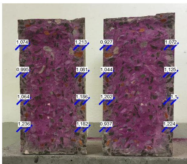
Figura 4. Carbonatação do concreto com substituição de 10% do agregado graúdo
