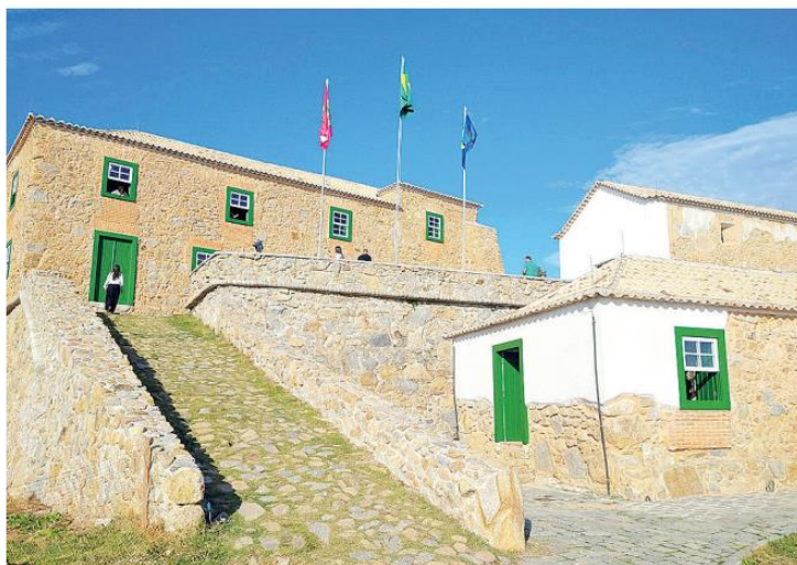
Fortaleza São José da Ponta Grossa, localizada na Praia do Forte
