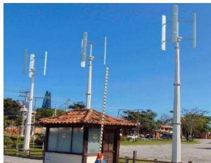
Figura 20: Gerador Eólico em manutenção no Porto da Barra. Fonte: Autores, 2018.
