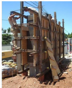
Figura 7: construção de parede em taipa. Fonte: BT betão e taipa, Lda.
