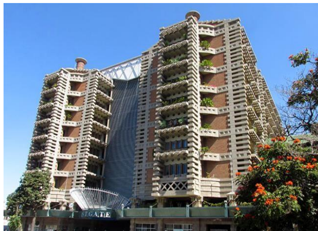
Figura 10: Fachada do Eastgate Building. Fonte: http://www.condominiosverdes.com.br/voce-ja-ouviu-falar-em-biomimetica/
