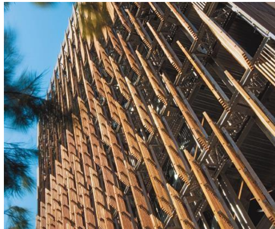
Figura 8: Os painéis de controle solar na fachada oeste do edifício. Fonte: http://www.urbanthriving.com/news/council-house-2-council-house-1/
