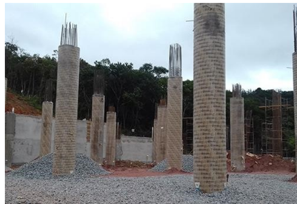
Figura 9: Estruturas com fôrmas de tubos de papelão. Fonte: Concretubo - https://goo.gl/mU9aQW
