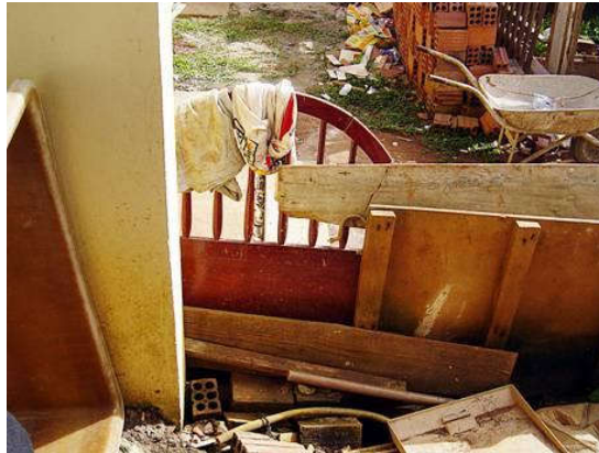
Figura 3: Solução para espaço com a reutilização de cabeceira de cama como parte do muro. Fonte autores.
