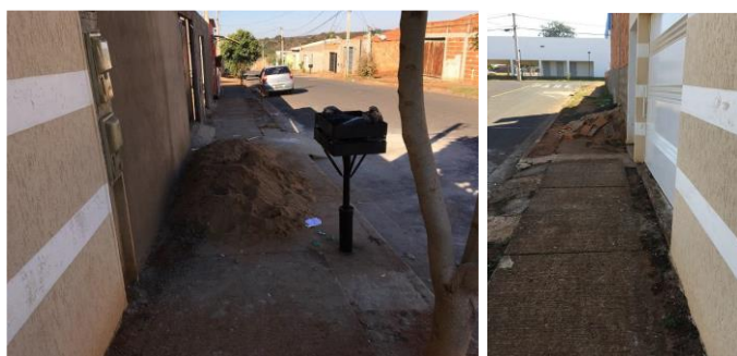
Figura 12: Rejeitos de Construção Civil nas Calçadas. Fonte: VILLA, S. B.; et al.,2017.
