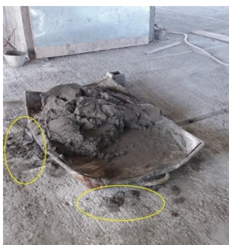
Figura 5: Desperdício de argamassa estabilizada. Fonte: elaborado pelos autores.
