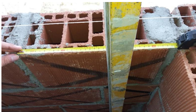
Figura 3: Bloco assentado com comprimento de 33 cm. Fonte: elaborado pelos autores.
