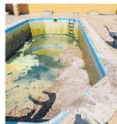
Para evitar o acúmulo de água parada, foi colocada areia dentro da piscina
