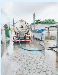
Hidrojetado da prefeitura foi utilizado na travessa Lambari, no Ingleses
