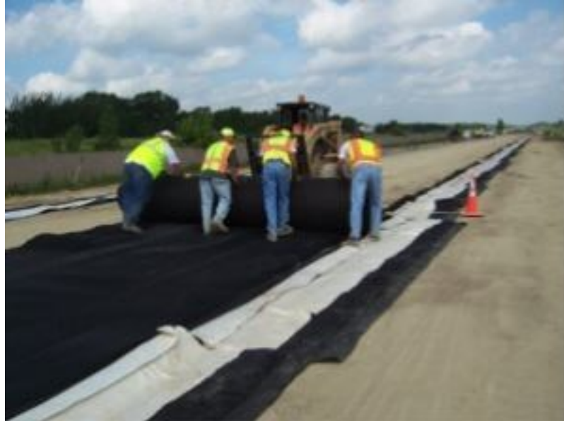
Figura 51 Geocomposto Drenante entre as camadas do pavimento
