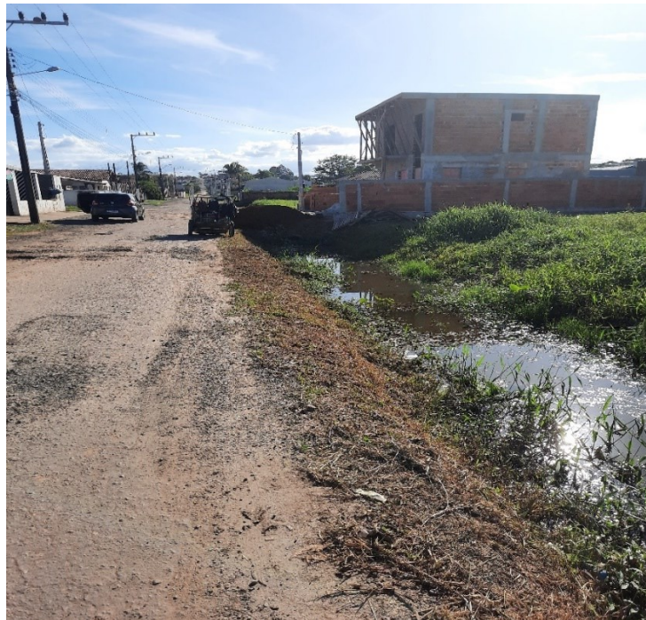
Figura 12 Trecho da Rua Manoel Correa em Barra Velha mostrando o acúmulo de água.
