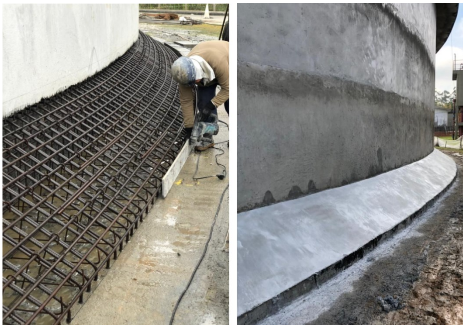
Figura 82 - Mísula do reforço estrutural
