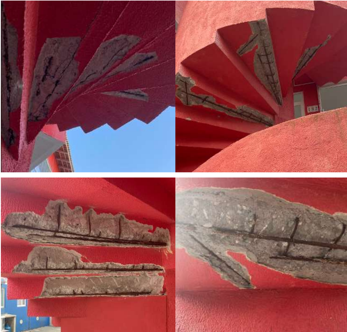
Figura 25 - Detalhe de escadas do empreendimento
