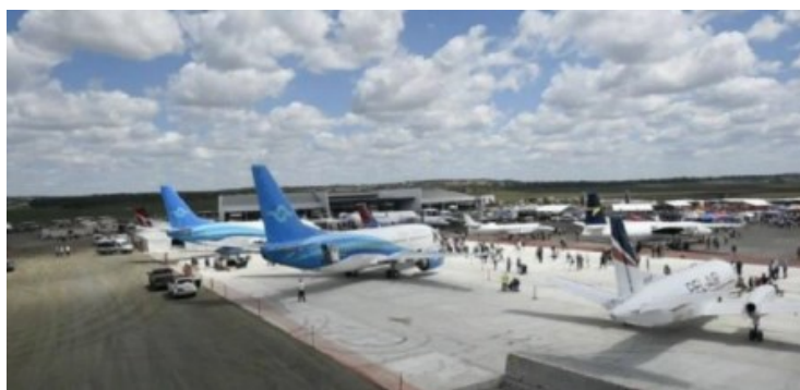
Figura 5 – Pavimento do Aeroporto Brisbane West Wellcamp (Austrália) em geopolímero.
