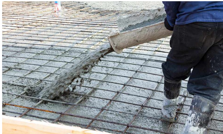
Figura 2 – Aplicação do concreto geopolimérico em laje.
