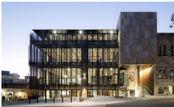
Figura 4 – Estrutura da Universidade de Queensland (Austrália) em geopolímero.
