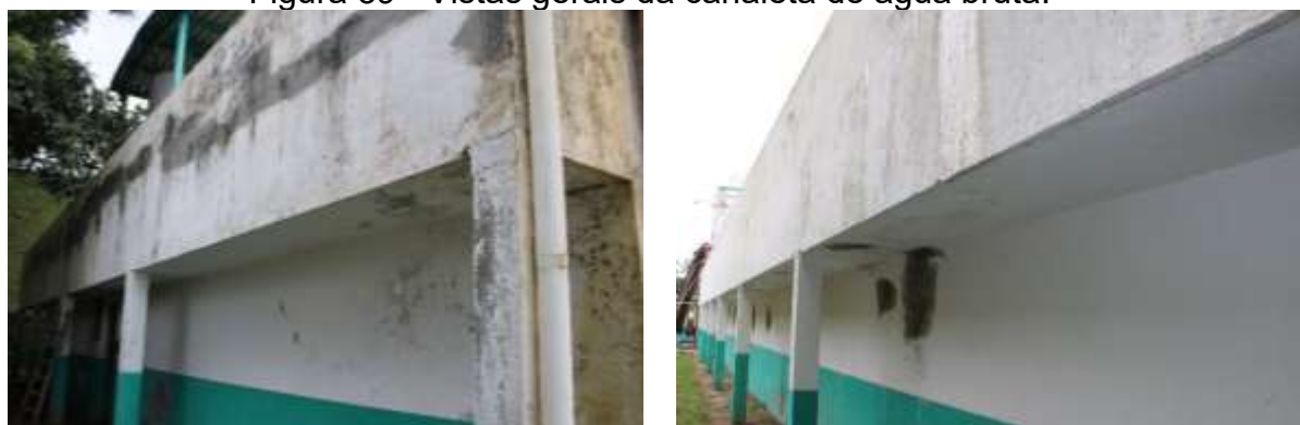
Figura 39 - Vistas gerais da canaleta de água bruta.
