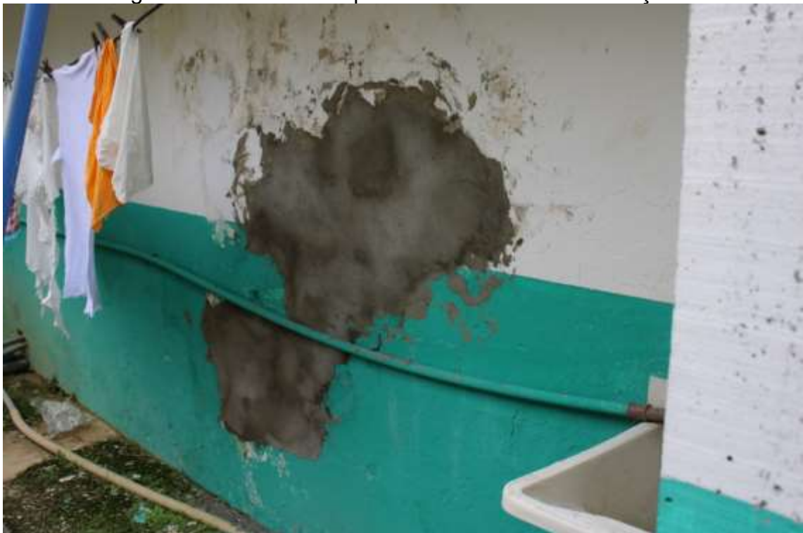
Figura 89 – Tratamento paliativo em área com infiltrações.
