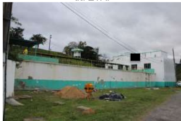
Figura 16 - Foto das condições atuais da ETA.
