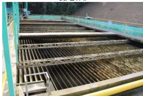
Figura 14 – Foto das condições atuais da ETA.
