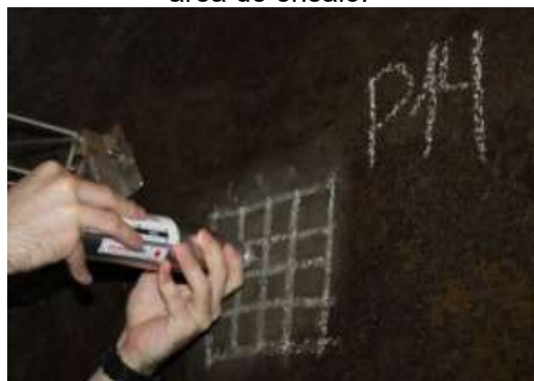
Figura 24 - Execução dos impactos em área de ensaio.
