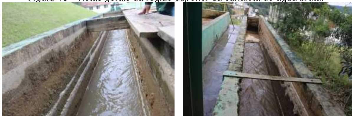
Figura 40 - Vistas gerais da região superior da canaleta de água bruta.
