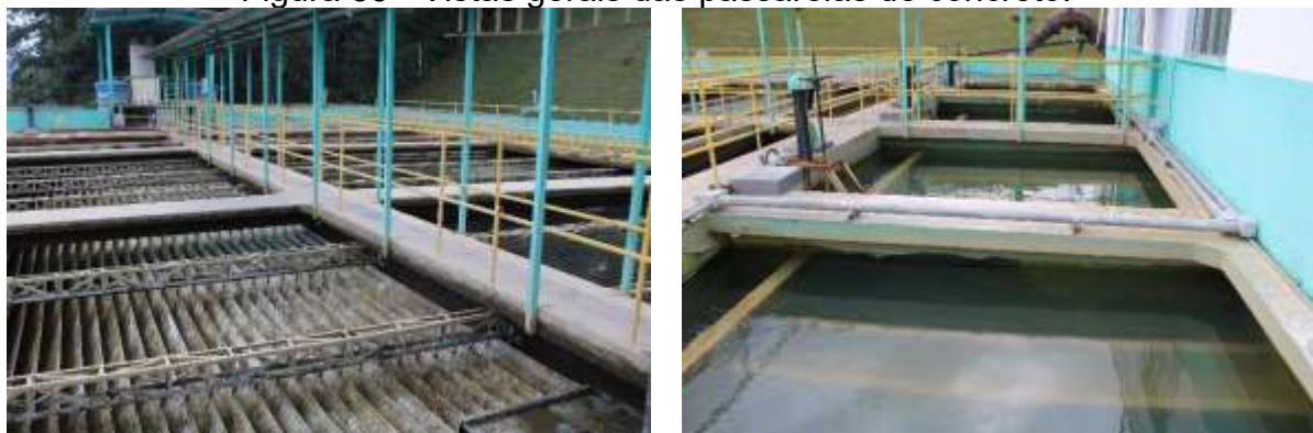
Figura 53 - Vistas gerais das passarelas de concreto.
