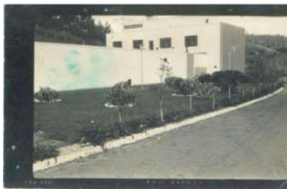
Figura 15 - Imagem geral da ETA.
