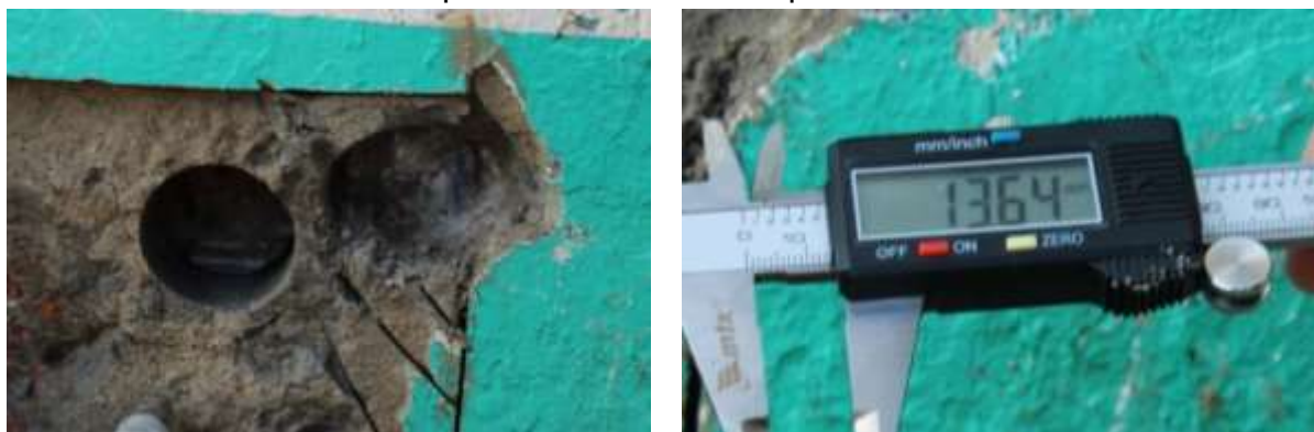
Figura 28 – Medições de armadura após abertura para extração de testemunho. Ressalta-se que existe um pequeno erro na medição, visto que não foi possível realizar a devida limpeza no concreto nas proximidades das barras.
