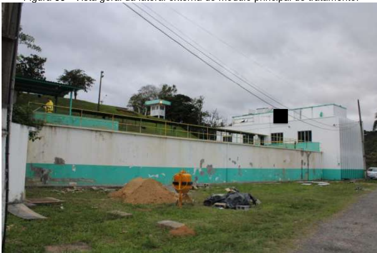
Figura 83 - Vista geral da lateral externa do módulo principal de tratamento.
