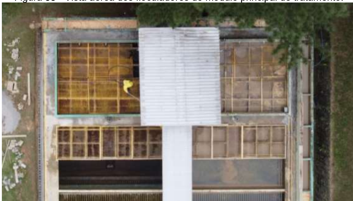
Figura 58 - Vista aérea dos floculadores do módulo principal de tratamento.
