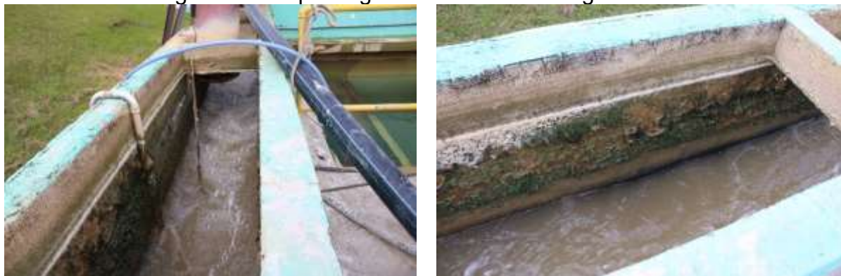
Figura 41 - Aspecto geral da canaleta de água bruta.
