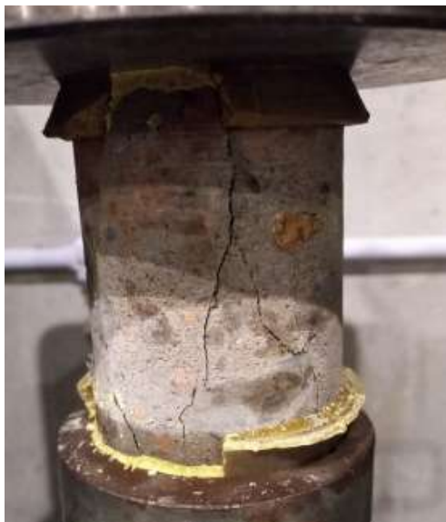
Figura 30 - Realização do rompimento do corpo de prova padrão extraído na 1ª vistoria.
