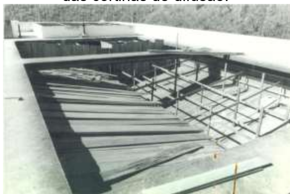
Figura 13 – Imagem do decantador e das cortinas de difusão.
