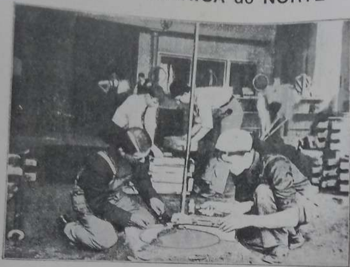
Fundição. Moldagem com gabarito
