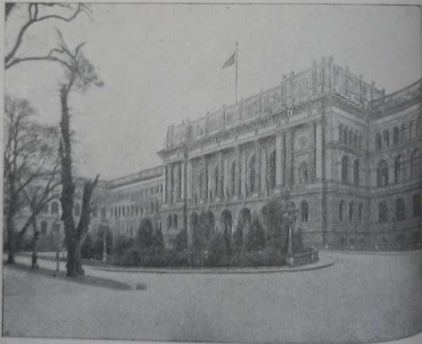
Vista da fachada principal
