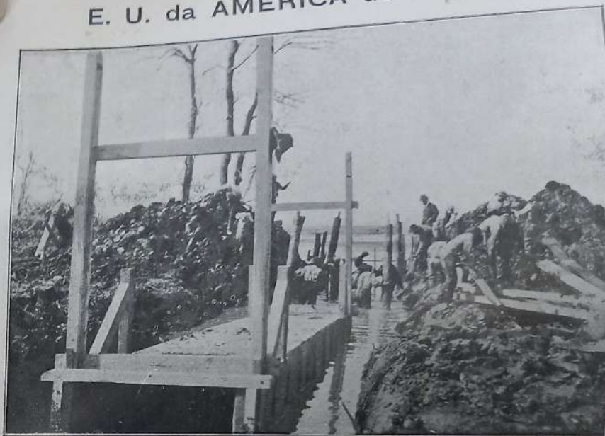
Um (trunk) eclusa para dar entrada da agua num arrozal em South-Carolina
