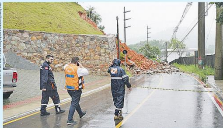
Defesa Civil de Palhoça interditou locais que tiveram quedas de barreiras no município na tarde de ontem
