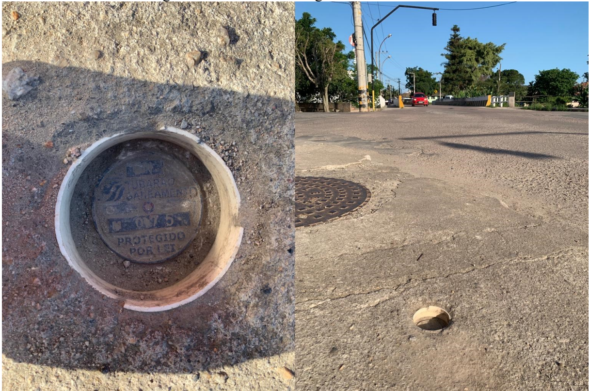
Figura 9 – Ponto de Checagem Fixado In Loco
