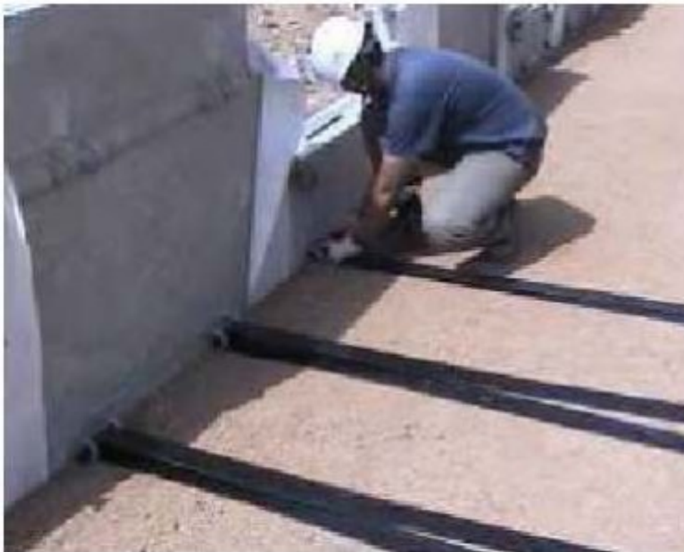
Figura 17 – Montagem da Terra Armada
