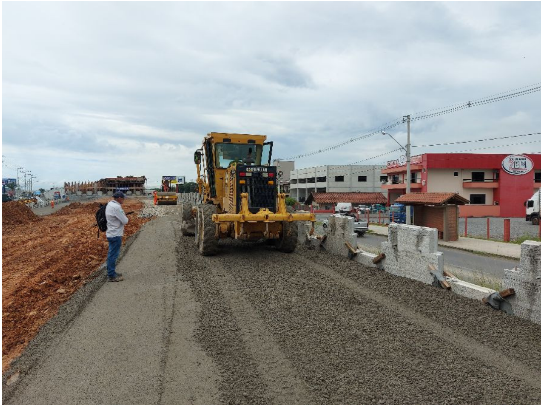
Figura 9 – Processo construtivo da Terra Armada
