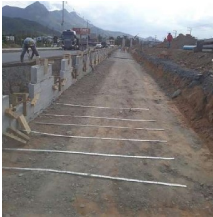
Figura 18 – Execução da Terra Armada
