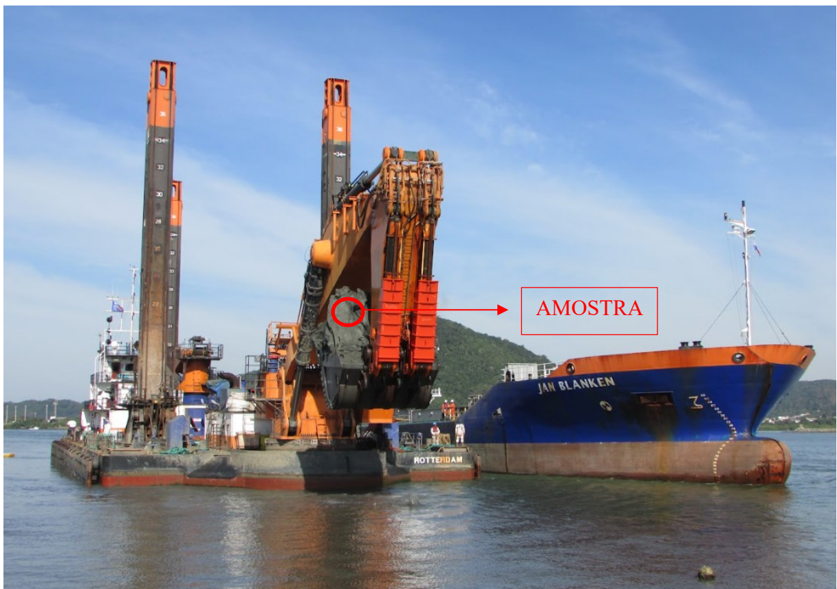
Imagem 10 – Identificação da amostra de solo na draga Backhoe Simson.
