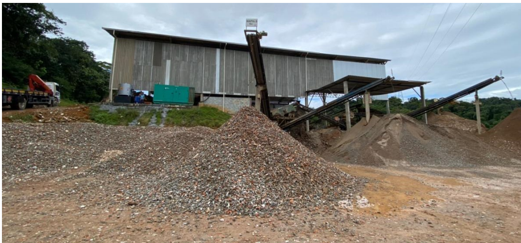
Figura 2.10 - Processo de britagem do RCD.
