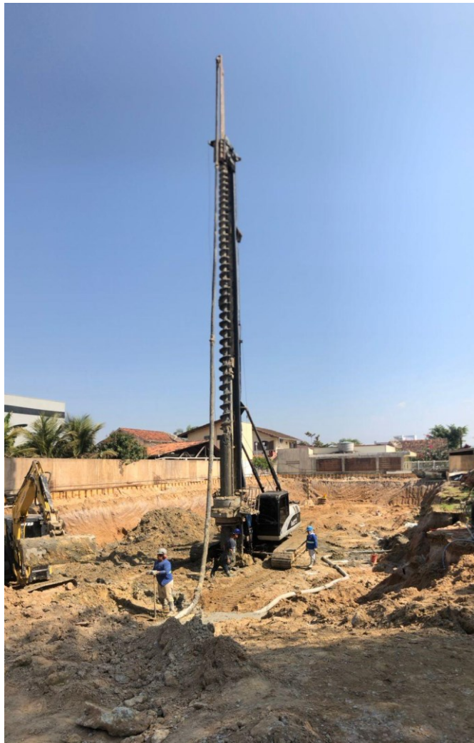
Figura 1 – Perfuratriz para execução de estacas hélice contínua
