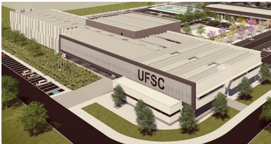
Figura 16 - Vista superior e platibandas bloco U da UFSC-Joinville
