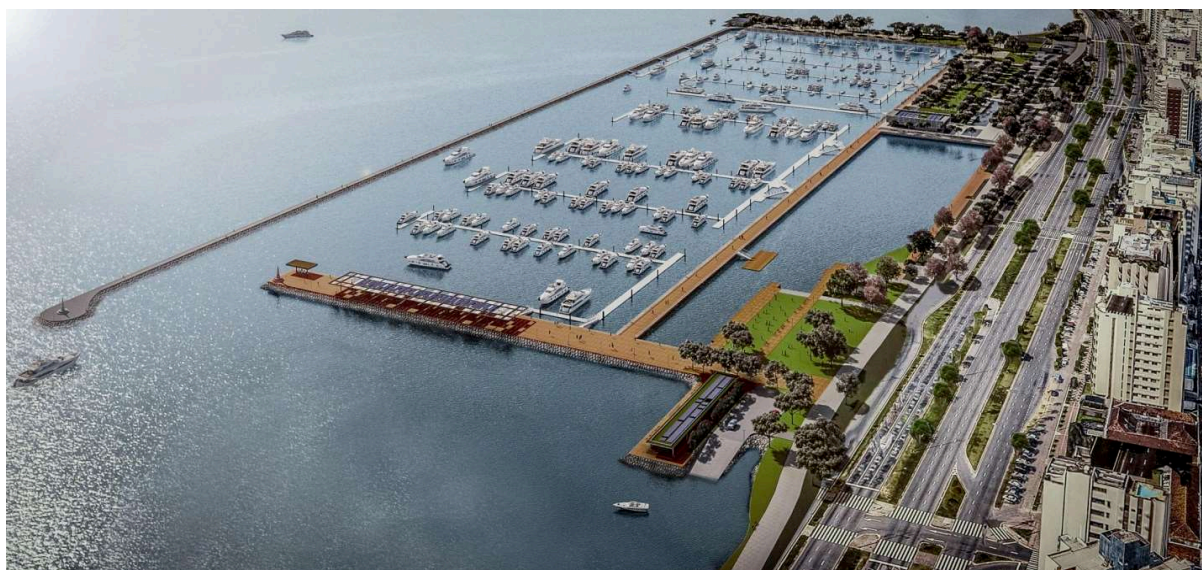
Figura 06: Parque Urbano e Marina da Beiramar/ Florianópolis
