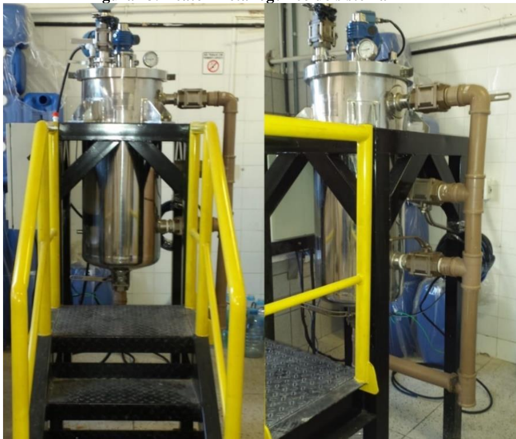
Figura 13. Reator metanogênico do sistema DADF
