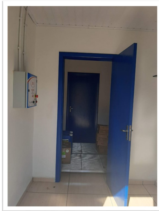
Figura 2 -Sala de fumigação
