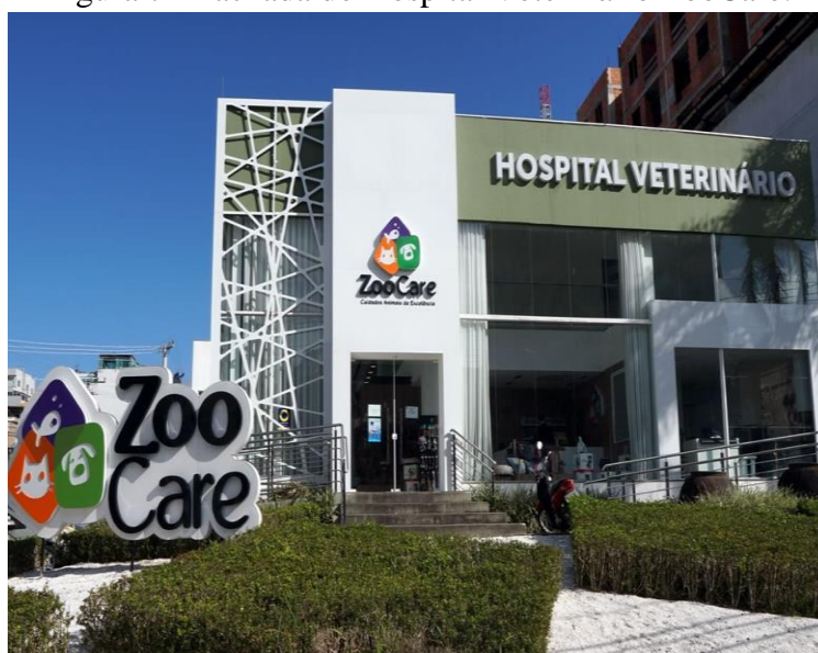
Figura 7 - Fachada do Hospital Veterinário ZooCare.
