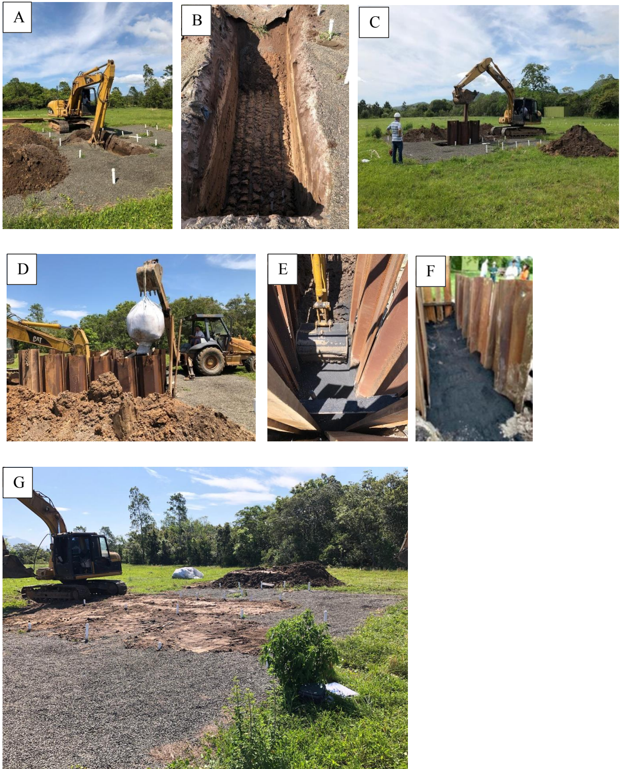
Figura 7 - Instalação da Barreira de Biocarvão de Casca de Arroz.
