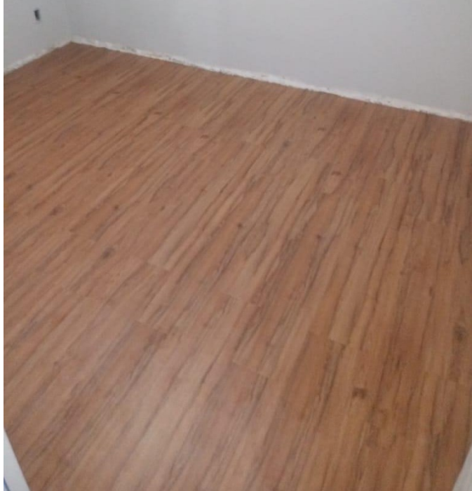
Figura 3 - Aplicação de piso vinílico numa sala de estar
