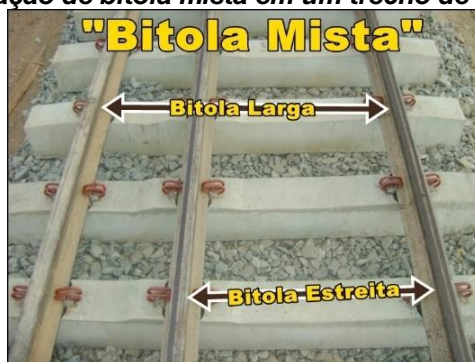
Figura 24 - Adaptação de bitola mista em um trecho de bitola larga – 1,6 m
