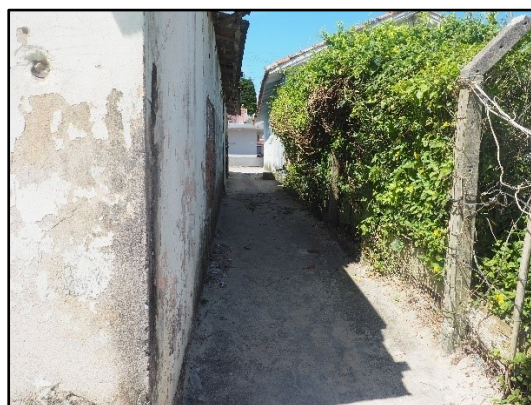
Figura 65: Corredor/Viela pedonal separando propriedades
