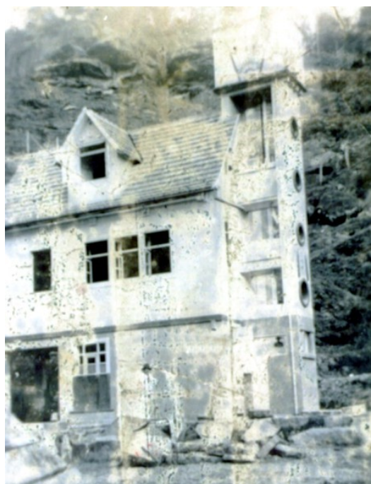
Fotografia 03: Ruínas da casa de Eduardo Hoerhann. Ano desconhecido. Foto: arquivo familiar.
