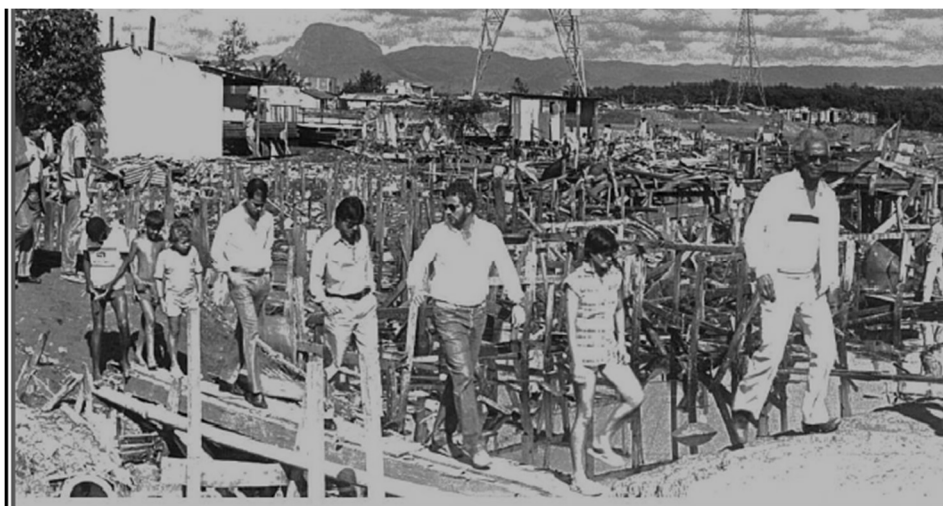
Fotografia 3 – Demolição de palafitas em Mangue Seco (Andorinhas – 1980)
