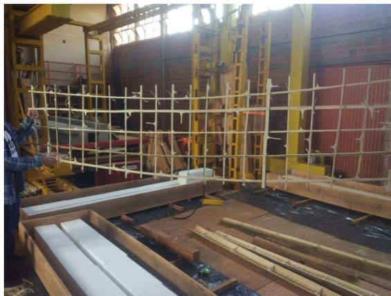
Figura 3 - Malha de filetes de bambu, amarradas com barbante de sisal. Fonte: Autores
