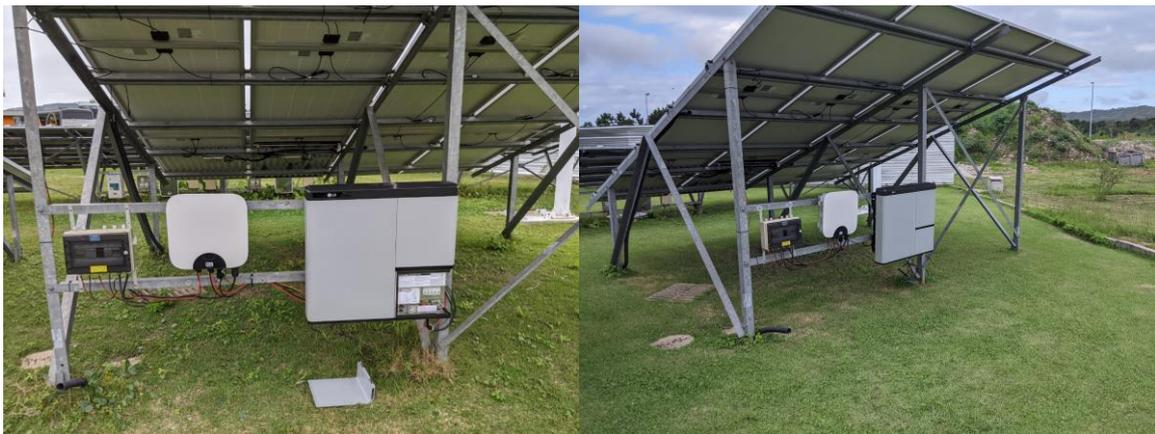
Figura 2. Sistema de armazenamento instalado no laboratório Fotovoltaica-UFSC (stringbox + inversor FV + bateria). Fonte: elaborado pelos autores.
