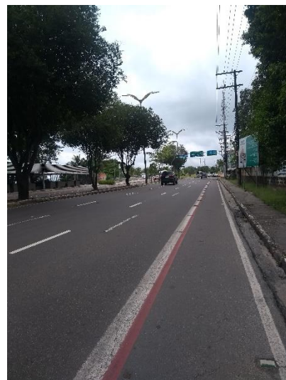
Figura 11: Trecho 1 depois da implementação do sistema. Fonte: Autor, 2021.
