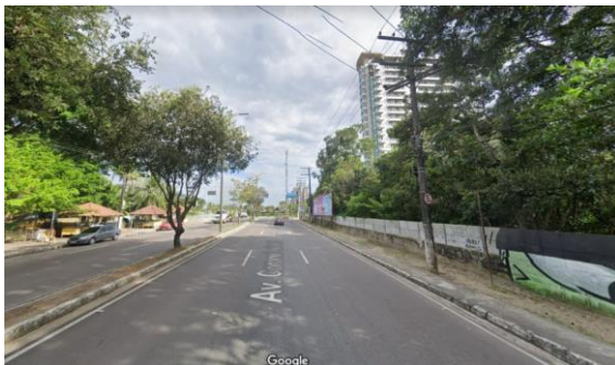
Figura 10: Trecho 1 antes da implementação do sistema. Fonte: Google, 2021.
