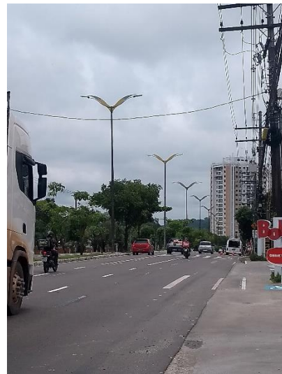
Figura 15: Trecho 3 depois da implementação do sistema. Fonte: Autor, 2021.
