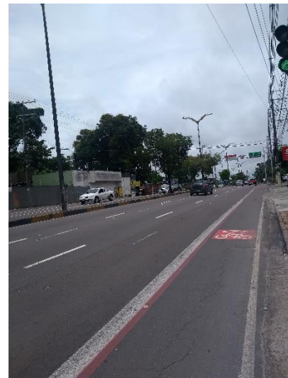
Figura 19: Trecho 5 depois da implementação do sistema. Fonte: Autor, 2021.
