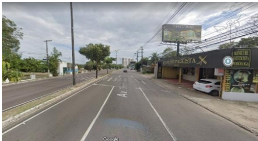
Figura 14: Trecho 3 antes da implementação do sistema. Fonte: Google, 2021.
