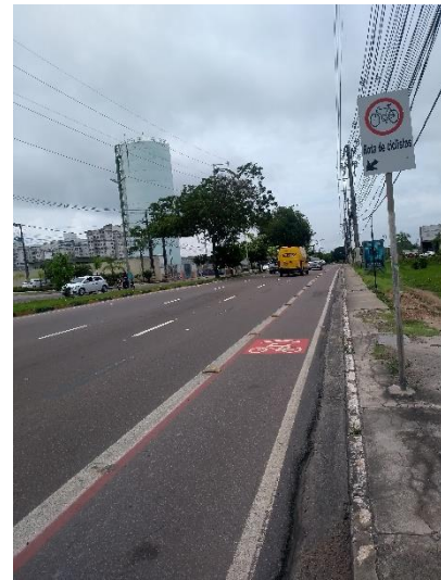
Figura 17: Trecho 4 depois da implementação do sistema. Fonte: Autor, 2021.
