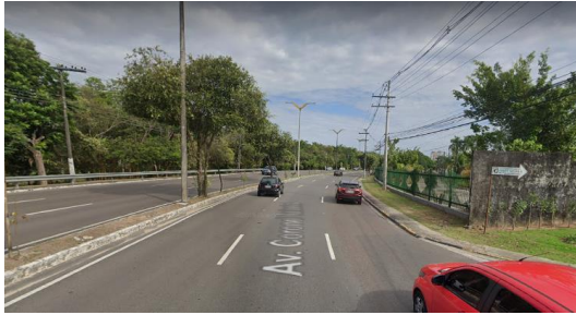
Figura 12: Trecho 2 antes da implementação do sistema. Fonte: Google, 2021.
