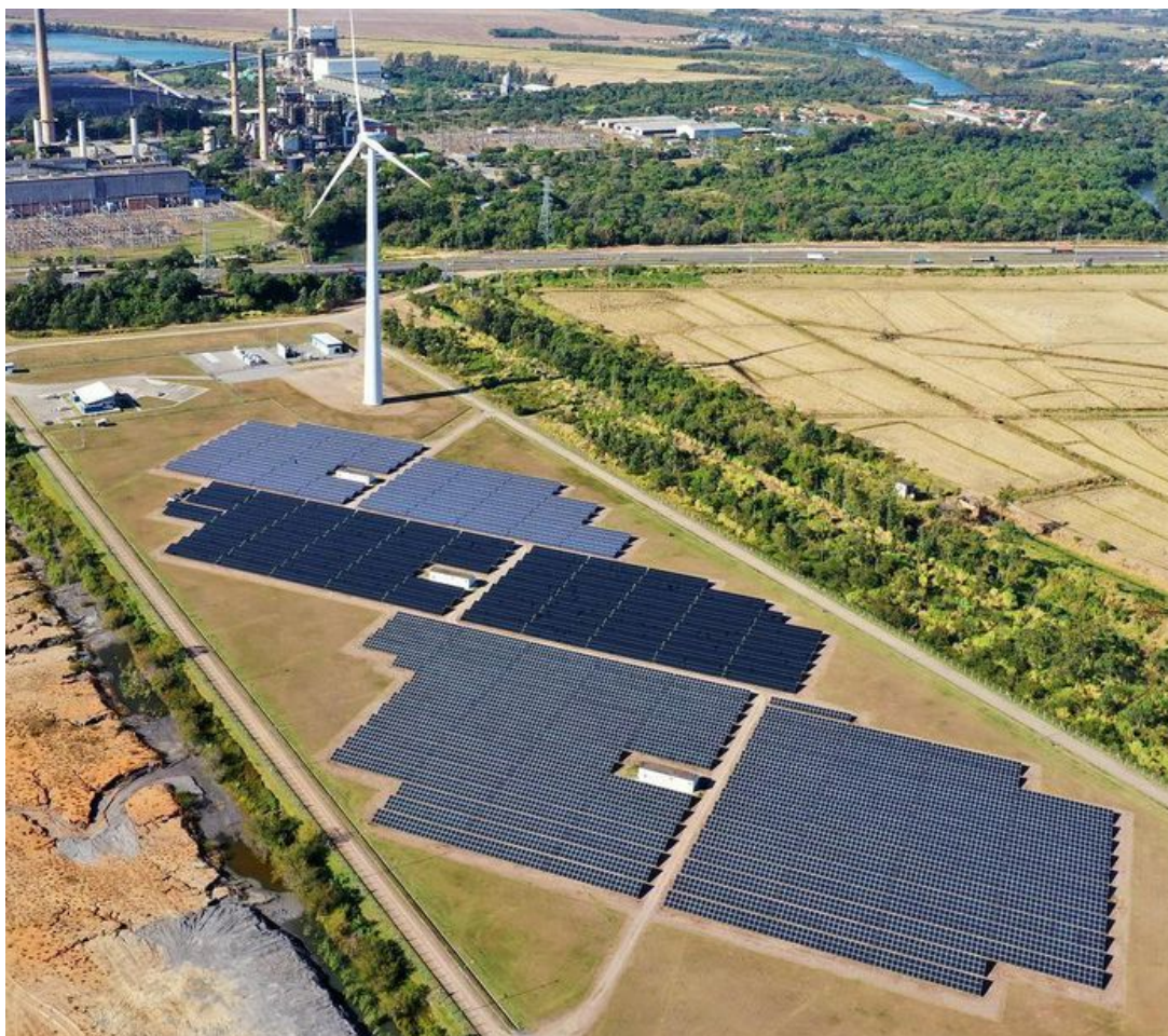
Figura 1 – Usina Solar Cidade Azul e Central Eólica Tubarão
